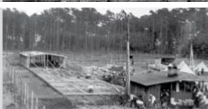
3. Budowa powojennych karaków w Stutthofie, 1939 r.
